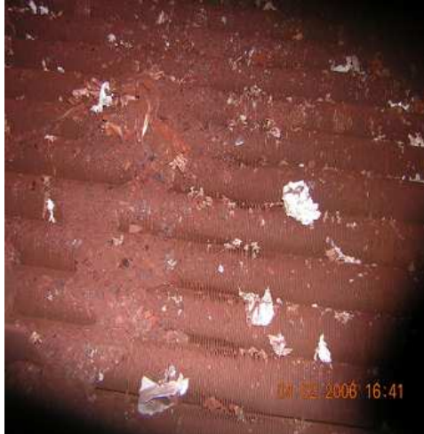
Rostpartikel auf den Rohren
